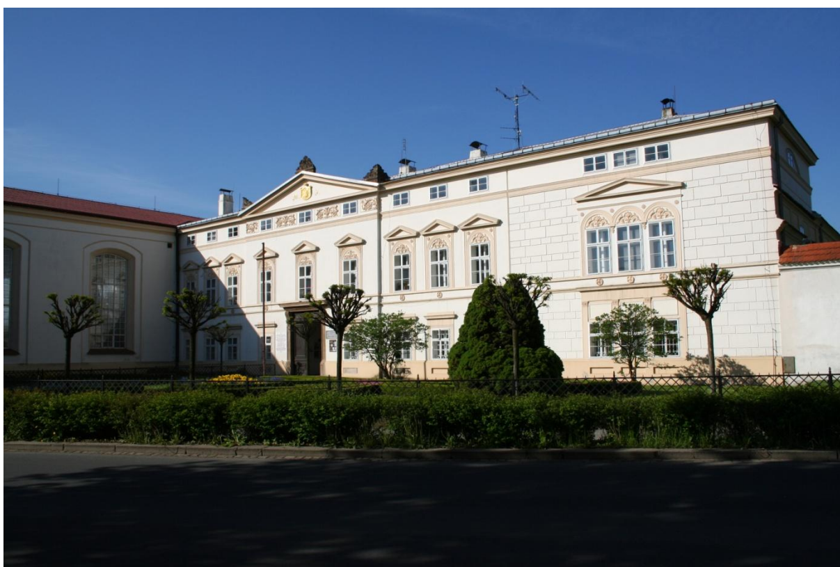
obr. 43 - vstupní objekt Květné zahrady v Kroměříži
