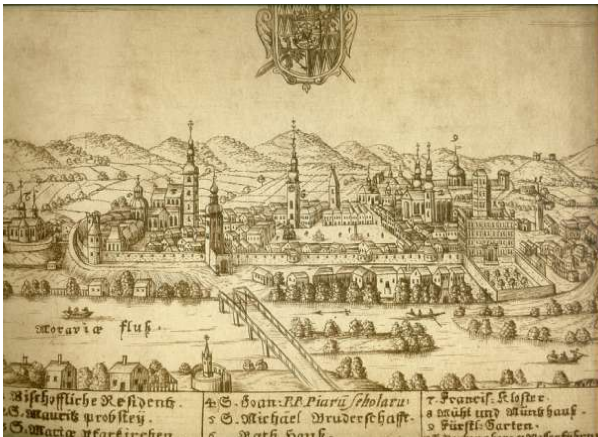
Obr. 11. Veduta Kroměříže z konce 17. století se znakem biskupa Karla z Liechtensteinu-Castelkorna (1664–1695). V pozadí Květná zahrada s rotundou označenou č. 9 (převzato z Motalík, Zdeněk (ed.): Kroměřížské veduty . Praha 2006, č. 2). Detail rotundy.
